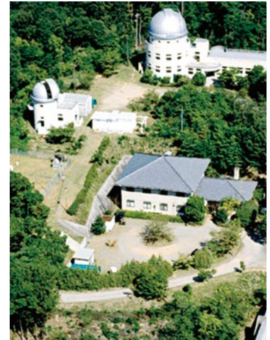
(中) 飛騨天文台全景 (岐阜県高山市) 天文台は、都会の光害やスモッグを避けて、空気の澄んだ高山の大自然の中に建設されている。左手奥は世界第一級の性能を持つドームレス太陽望遠鏡、左手前は最新の太陽磁場活動望遠鏡
